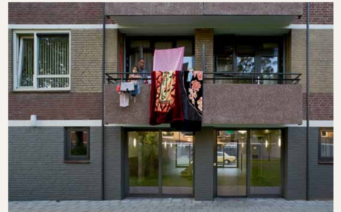
De renovatie van vijf portiekflats uit 1970 in de wijk Schuilenburg te Amersfoort is door Van Schagen Architecten uitgevoerd in opdracht van de Alliantie. De technische opgave betrof het verbeteren van de energieprestatie en het vervangen van afgeschreven ramen en hekwerken. Door de entrees te verbreden en tot aan de achterzijde door te breken, is een ruime entreehal gecreëerd die toegang biedt tot het achterliggende groengebied. Foto Stijn Brackee
